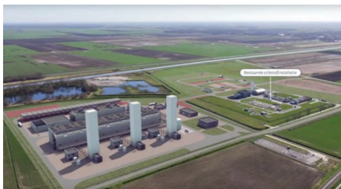
Impressie nieuwe stikstofinstallatie
